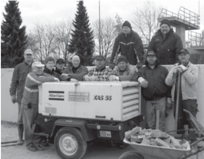
Bei den aufwändigen Renovierungsarbeiten im Freibad kann sich der Trägerverein auf seine „Männergruppe“ verlassen. In einem ersten Bauabschnitt wurde die Beckenumrandung im Schwimmer- und Springerbereich erneuert. Jeden Samstagmorgen ab 8:30 Uhr rückt der Trupp an. Die Männer sind nicht abgeneigt, den ein oder anderen Mitstreiter in ihre Reihen aufzunehmen. Man muss ja nicht jeden Samstag dabei sein. Jörg Brey nimmt Anmeldungen entgegen (Tel. 6152)
